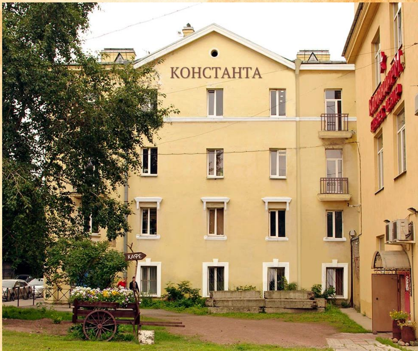
Офисное здание, ранее жилой дом. Год постройки примерно 1908 . Огородный переулок, дом 21
