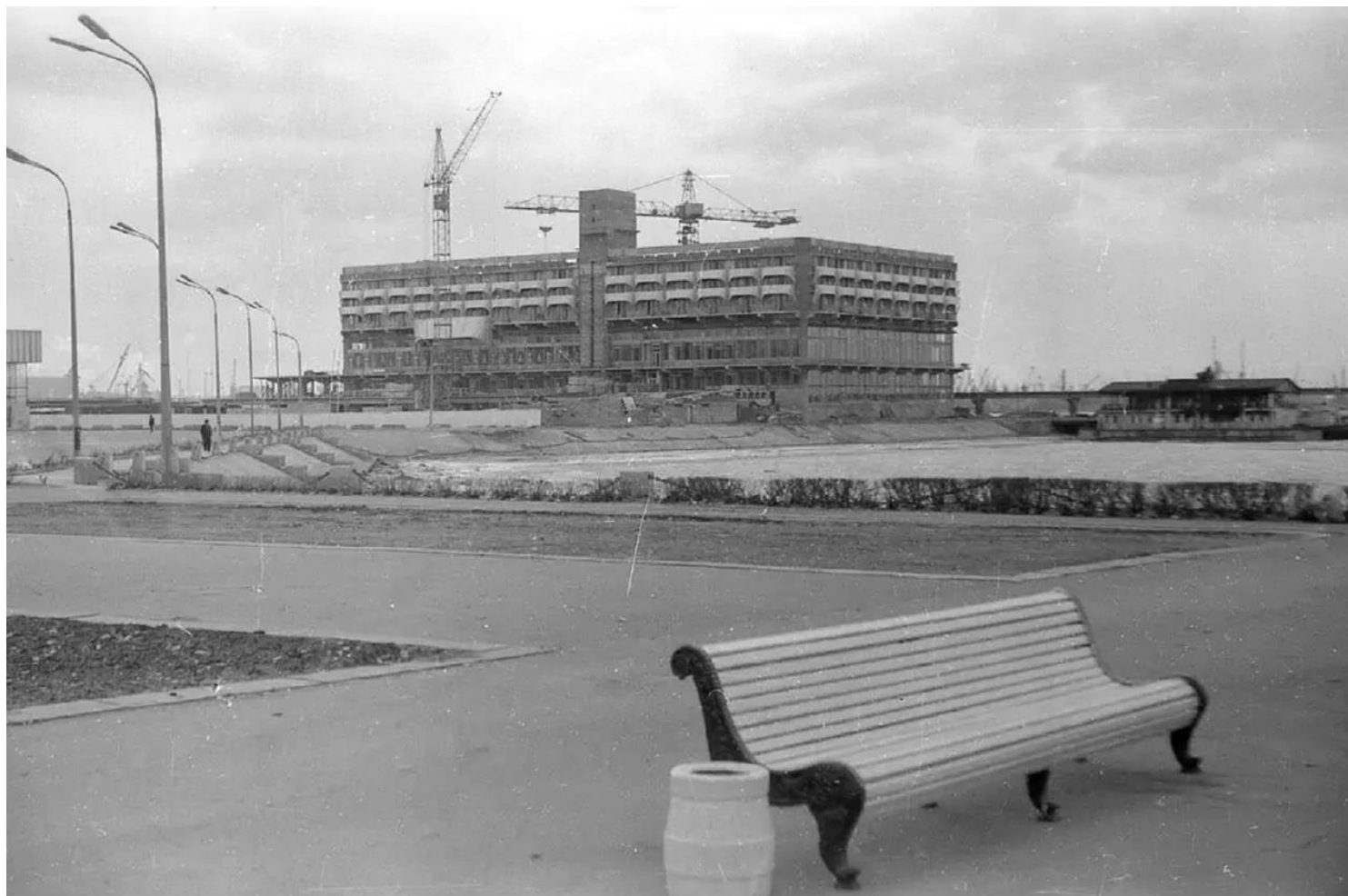
Строительство Морского вокзала, 1980 г.
